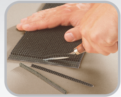
Rebaixe a cobertura de impressão.
