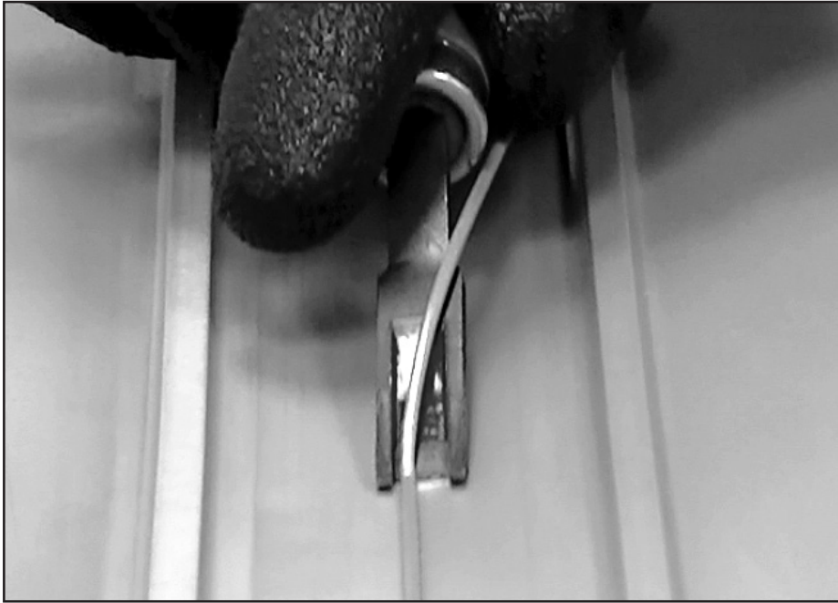
使用去皮工具去除底侧焊缝。
