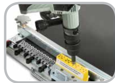
电动铆钉钻安装
