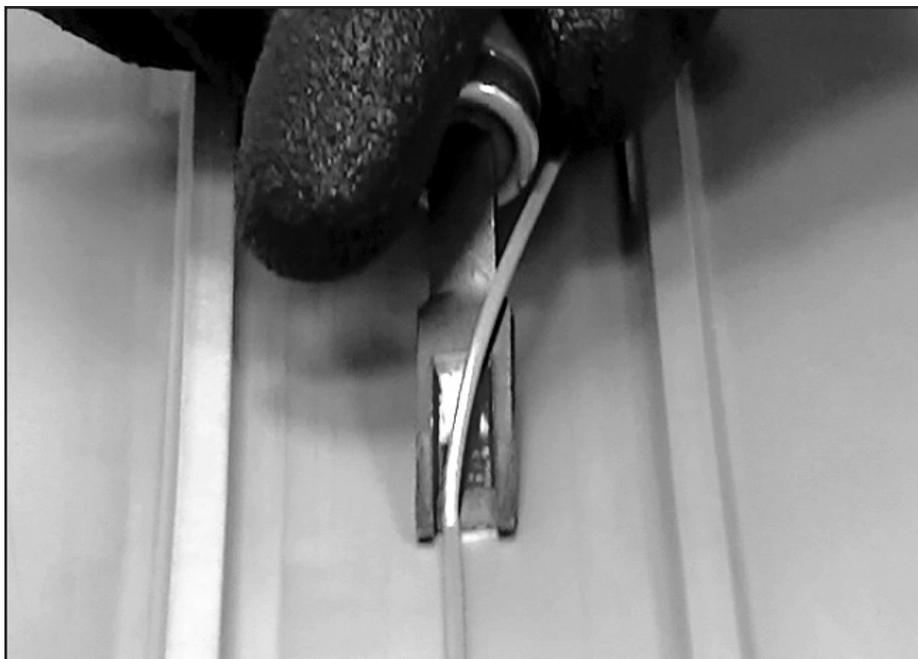
Die Verbindungsnaht an der Unterseite mit einem Bandhobel glätten.
