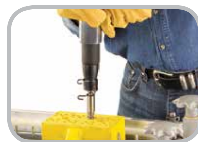
Instalação de rebitador pneumático
