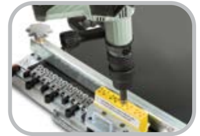
电动铆钉钻安装
