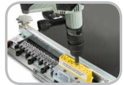
电动铆钉钻安装
